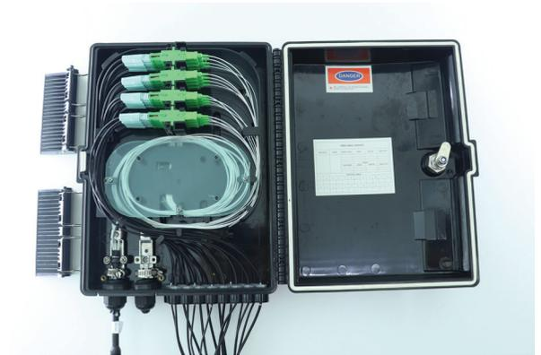
Realize a montagem dos conectores e organize os cabos drop como no exemplo acima, é importante que respeite os raios de curvatura da fibra para obter um bom desempenho da CTO.
